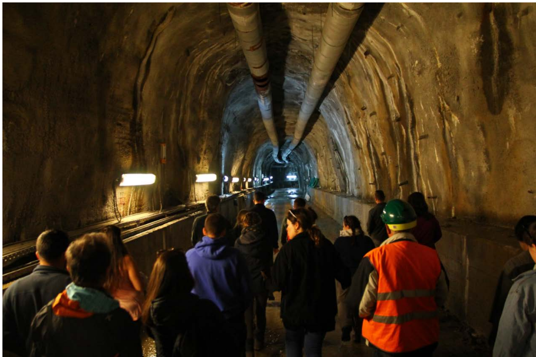
Εκπαιδευτική εκδρομή φράγμα Ευήνου σήραγγα προσπέλασης θαλάμου θυροφράγματων εκκένωσης.
