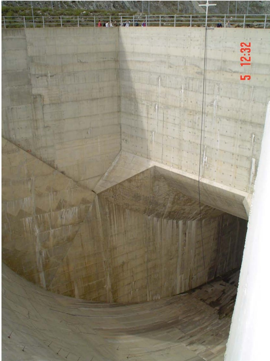
Εκπαιδευτική εκδρομή φράγμα Ευήνου υπερχειλιστής (ύψος 35m).
