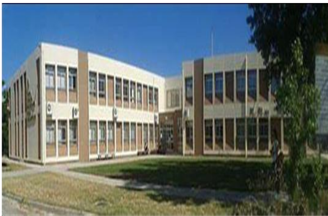
Όψη του κτιρίου του Τμήματος Νοσηλευτικής
