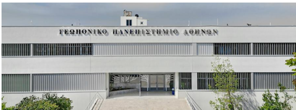
Είσοδος στο Κτίριο Ρουσσόπουλου - Τμήμα Αξιοποίησης Φυσικών Πόρων και Γεωργικής Μηχανικής
