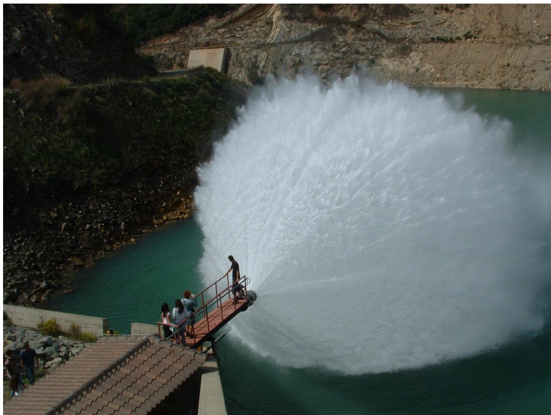
Εκπαιδευτική εκδρομή φράγμα Ευήνου Δικλείδα περιβαλλοντικής παροχής.
