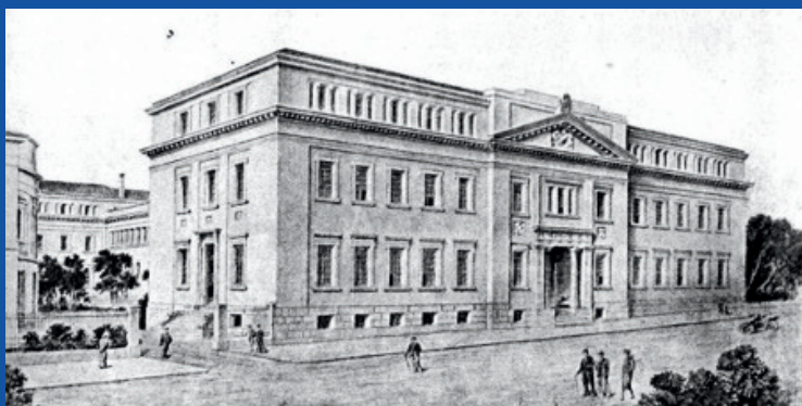
Προοπτικό (από την οδό Στουρνάρη) του κτηρίου Γκίνη που κατασκευάστηκε την περίοδο 1930-35, στο οποίο στεγαζόταν η Σχολή Πολιτικών Μηχανικών το υπόλοιπο διάστημα του 20ου αιώνα μέχρι το 2003
